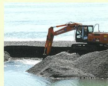
重機による河口開削の様子
