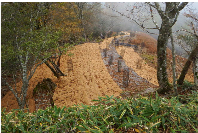
2015年 柵下段の表土流出地にマットを張り、ブナ苗を植栽
