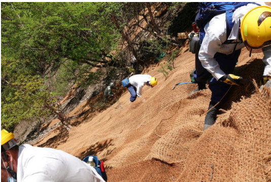
右写真の下部は急傾斜地となっていて裸地・崩れ地をマットを張り再生を目指す
