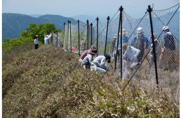
右写真の下部は急傾斜地となっていて裸地・崩れ地をマットを張り再生を目指す
